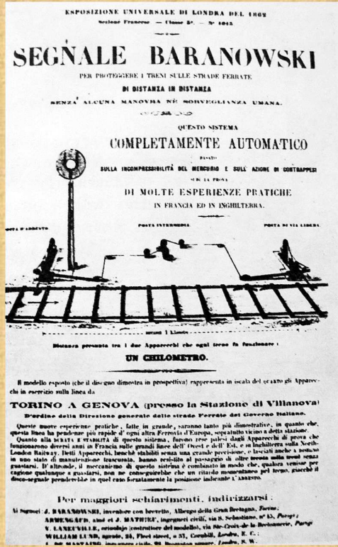
Automatyczny system sygnalizacji kolejowej. Semafor wymyślony przez Baranowskiego w 1857 roku
